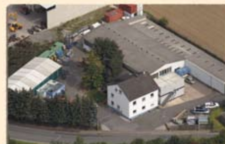
Luftaufnahme des Tipp-Firmengeländes kurz nach den Umbauarbeiten
